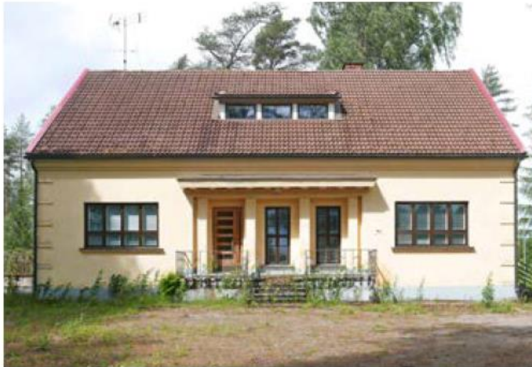
Kuva 18. Vankilanjohtajan asuintalo Urheilukentäntien alueella.
