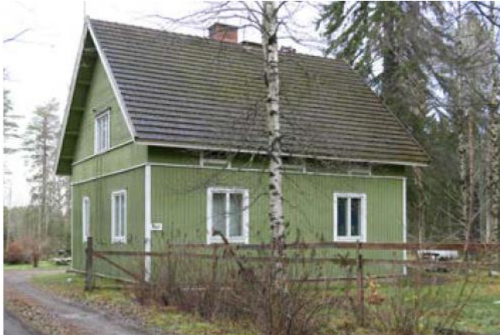
Kuva 20. Vankilanjohtajan asuntona toiminut asuinrakennus Päivärinteellä
