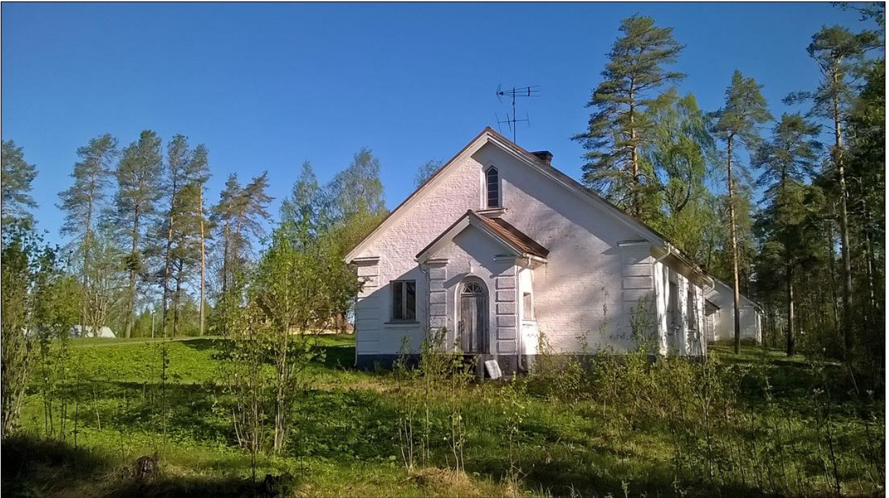
Kuva 5: Kortekankaalla on suhteellisen hyväkuntoisia rakennuksia ilman asukkaita
