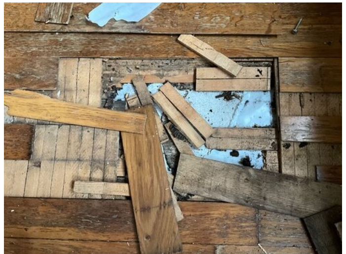
Kuva 4 Kuva lattiarakenteesta, betonin päällä lautaparketti.
