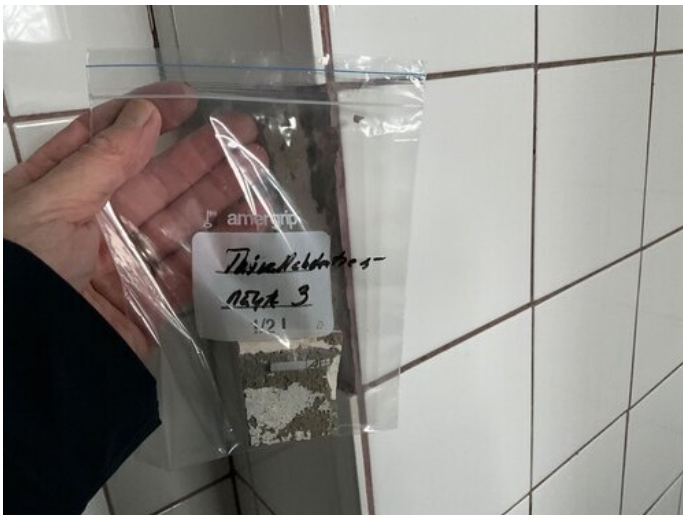
Kuva 3 Näytteenottoa kylpyhuoneen seinässä
