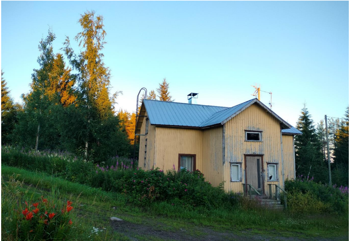
Kallioharjun autiotalo, jossa on sähkö ja peruslämpö.
